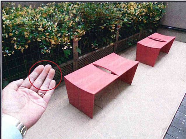
部位：テラスベンチ（４F） 塗膜の退色・チョーキング現象が進行しています。
