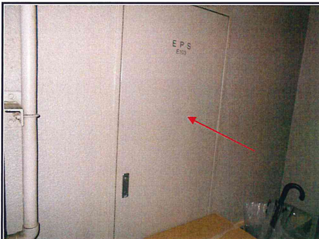
部位：EPS（E103）扉 塗膜の退色が進行しています。
