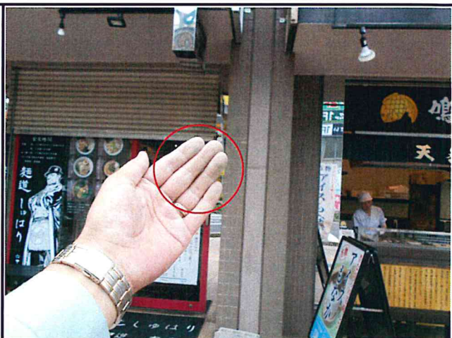
部位：店舗間化粧鋼板 塗膜の退色・チョーキング現象が進行しています。
