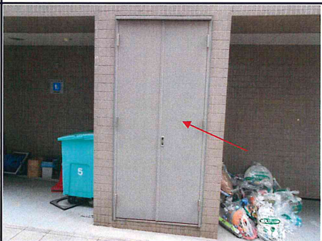
部位：ゴミ置き場扉 塗膜の退色が進行しています。
