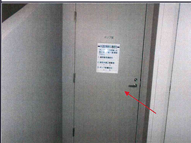
部位：ポンプ室扉（１F） 塗膜の退色が進行しています。
