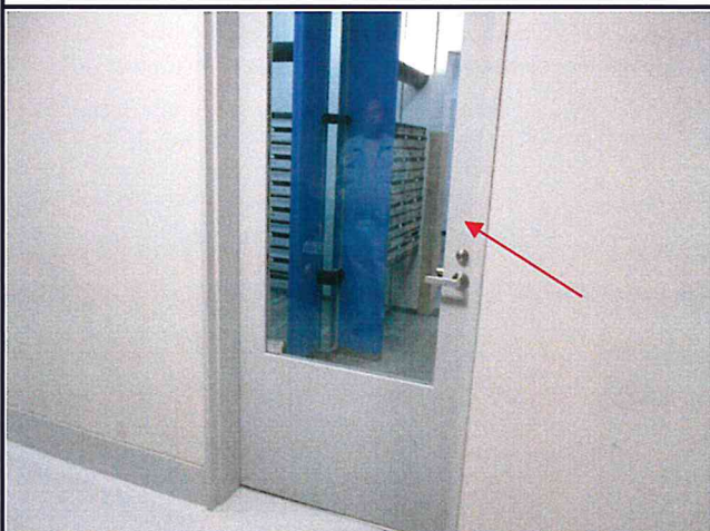
部位：メールボックス扉 塗膜の退色が進行しています。
