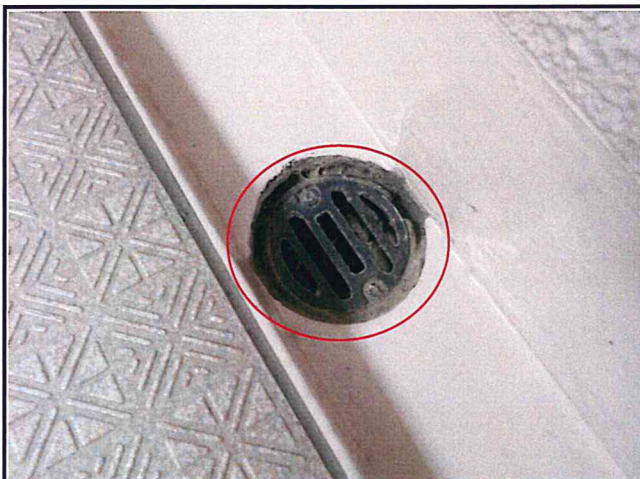
部位：廊下ドレン（１３Ｆ） 塗膜の退色が進行しています。
