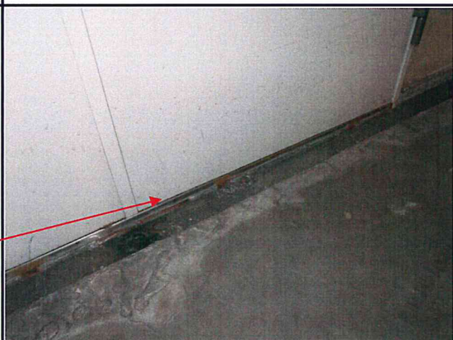
部位：同左クローズアップ 錆が発生しています。
