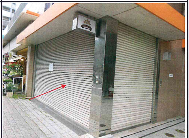
部位：シャッター南面 塗膜の退色、ハガレが見られます。
