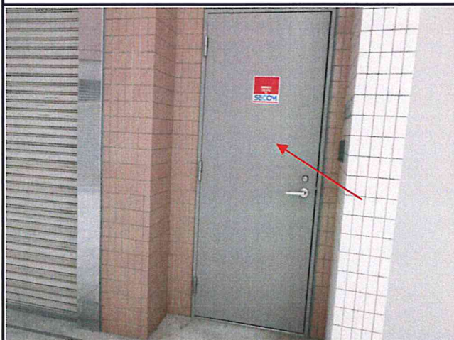
部位：防災センター通用口扉 塗膜の退色が進行しています。
