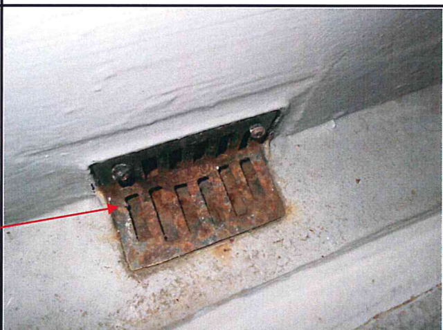
部位：同左クローズアップ 錆の発生が著しい状況です。
