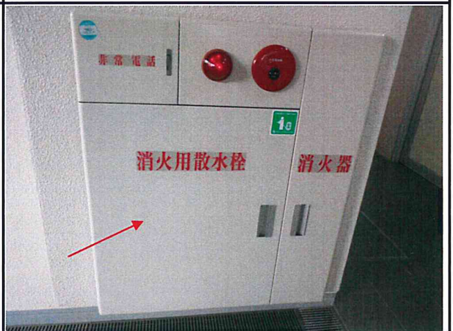
部位：消火用散水栓 塗膜の退色が進行しています。
