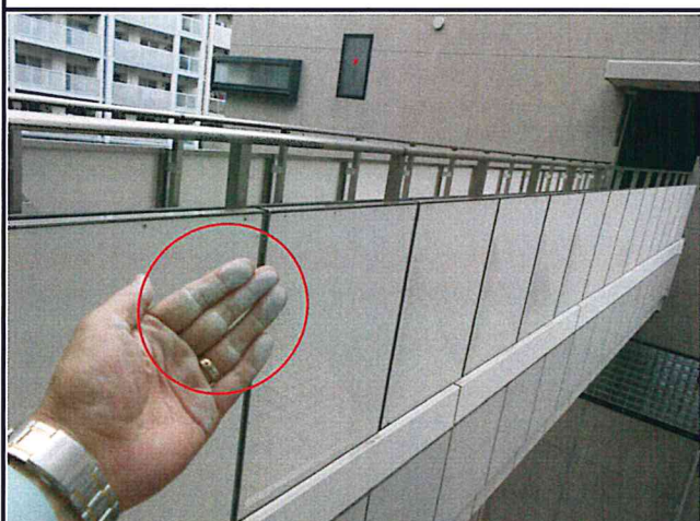
部位：渡り廊下手摺（4F） 塗膜の退色・チョーキング現象が進行しています。
